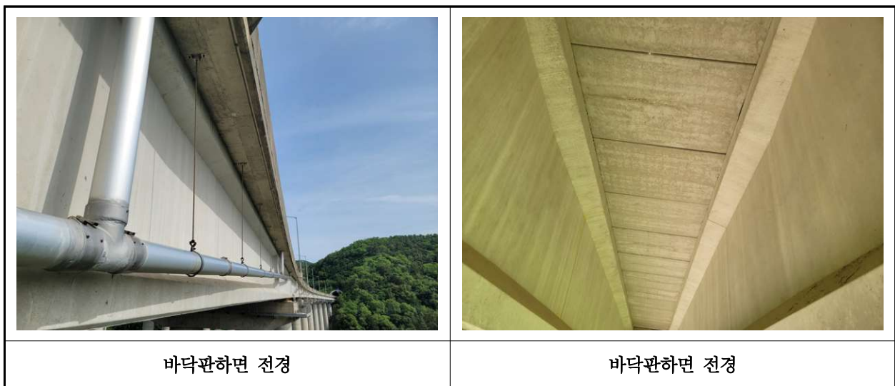
【사진 28.3.2】 바닥판하면 전경
