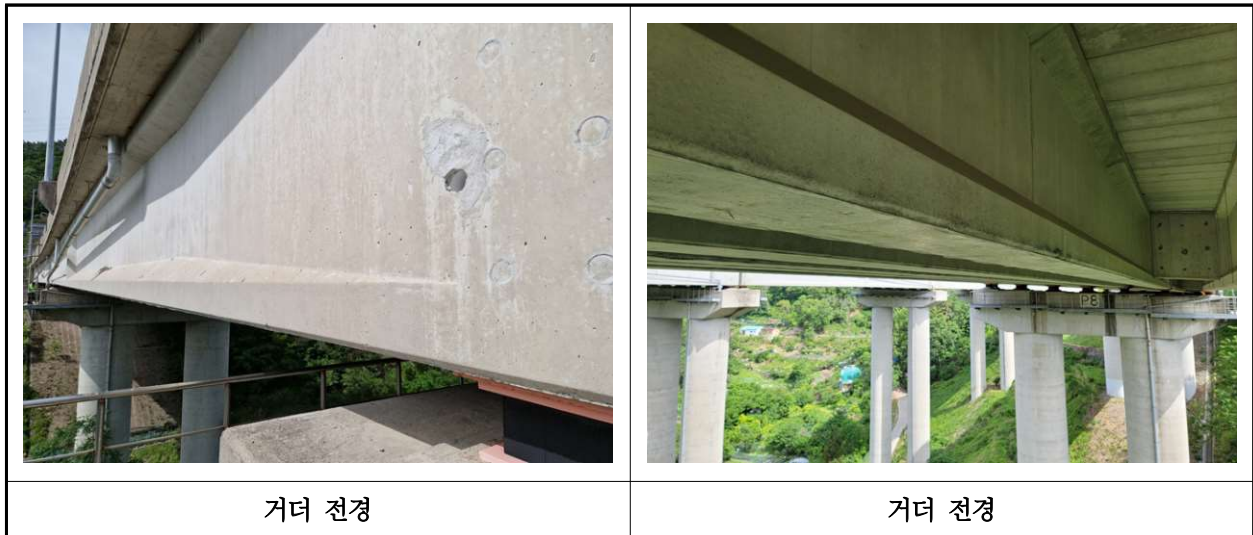
【사진 28.3.4】 거더 전경
