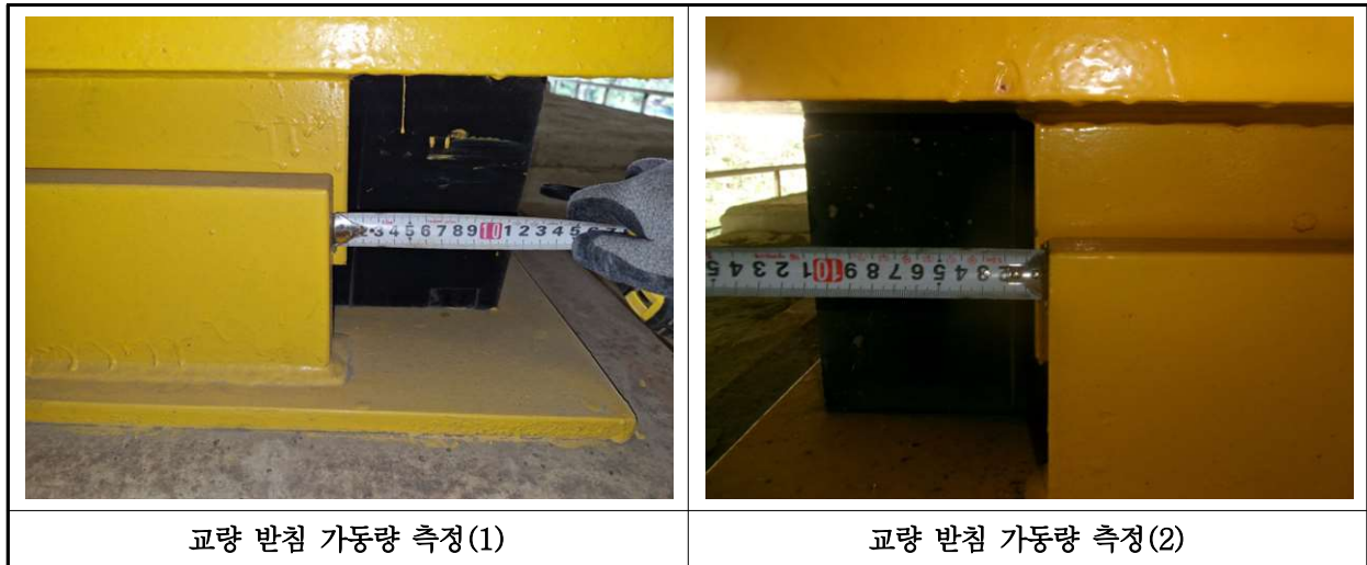
【사진 28.3.16】 교량받침 이동량 측정
