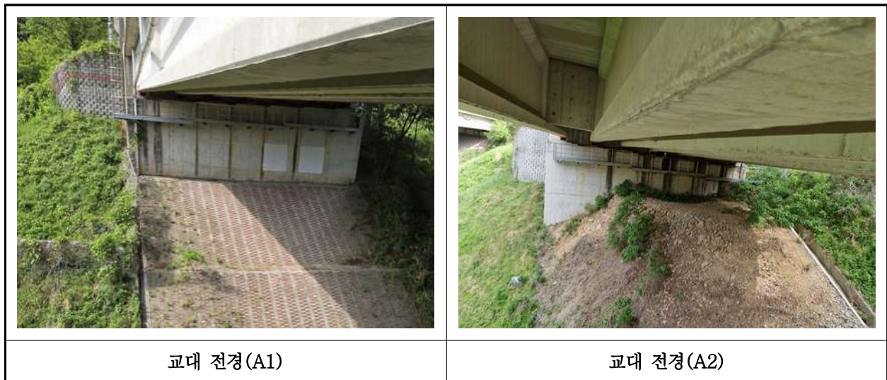
【사진 28.3.8】 교대 전경
