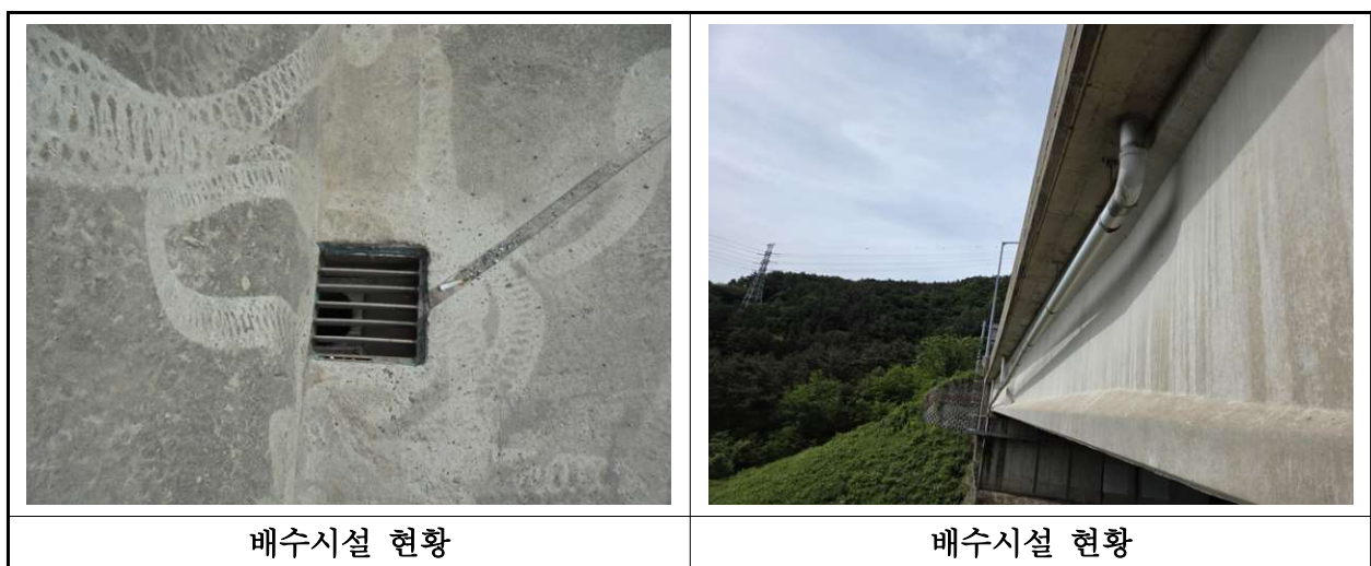
【사진 28.3.22】 배수시설 전경
