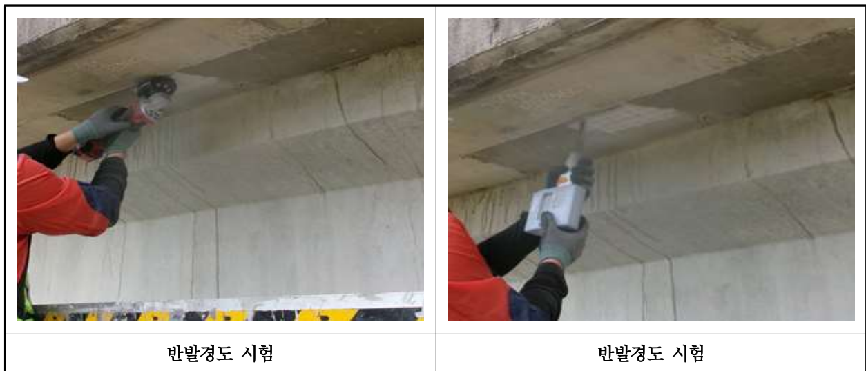
【사진 28.4.2】 반발경도시험 현장사진
